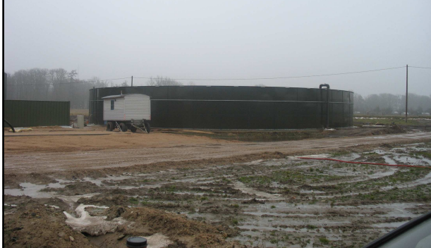
Šķidrmēsļu (digestāta) krātuves 4000 m 3 izbūve
