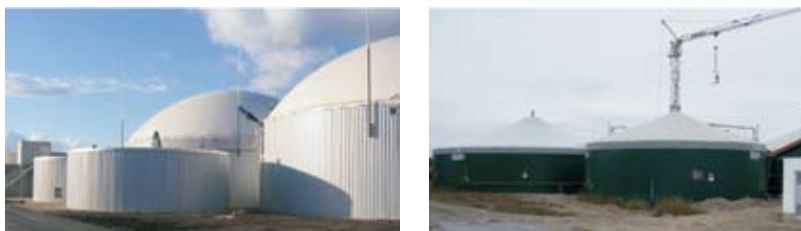
Slika 7.20. Vertikalni digestorji pokriti z zrakotesno membrano. Membrano napolni proizvedeni plin –levo (AGRINZ 2008); Vrh membrane je pritrjen na centralni steber –desno. Vir: RUTZ 2006
