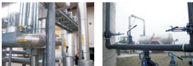
Slika 7.15. Izoliran plinovod -levo; Cevovod za presnovljeni substrat -desno. Vir: RUTZ 2008
