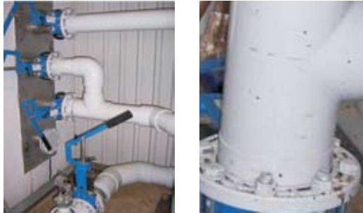
Slika 7.8. Zaporni ventili (levo) in črpalni sistem (desno). Vir: RUTZ 2006
