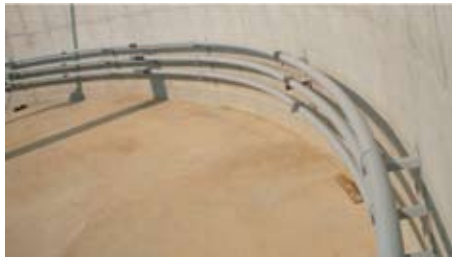
Slika 7.17. Ogrevalne cevi v digestorju. Vir: AGRINZ 2008
