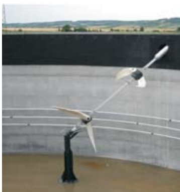
Slika 7.24. Lopatični mešalnik. Vir: AGRINZ, 2006
