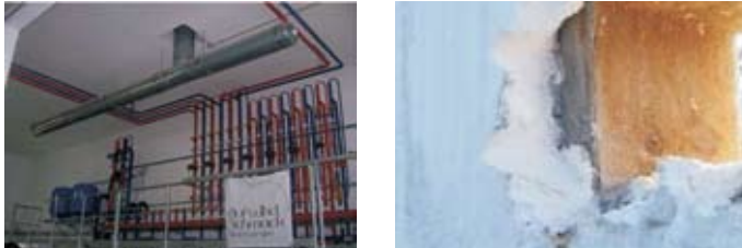
Slika 7.16. Ogrevalni sistem bioplinske naprave (levo) in izolacija betonskega digestorja v izgradnji (desno). Vir: RUTZ 2008
