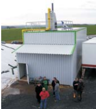
Slika 7.21. Horizontalni pretočni digestor. Vir: Rutz, 2006
