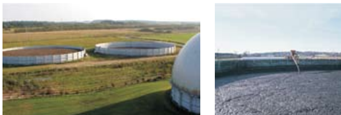
Slika 7.32. Skladiščni rezervoarji pokriti z naravno plavajočo plastjo. Vir: Danish Biogas Association, 2008
