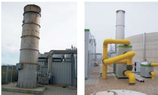
Slika 7.28. Sodobna bioplinska bakla. Vir: Rutz, 2007
