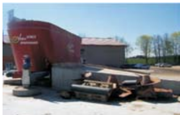
Slika 7.10. Dovodni sistem s kontejnerjem za suhi substrat – koruzno silažo in trdni perutninski gnoj (levo) in nakladalnik s koruzno silažo (desno). Vir: RUTZ 2008
