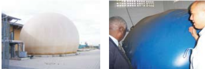
Slika 7.26. Zunanji skladiščni rezervoarji z nizkim pritiskom. Vir: RUTZ 2007
