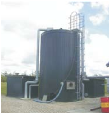
Slika 7.31. Reaktor za odstranjevanje vodikovega sulfida. Vir: Angelidaki, 2004
