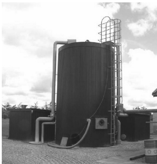
7.30.att. Reaktora tvertne biogāzes attīrīšanai no sērūdeņraža (ANGELIDAKI, 2005)
