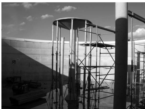
7.20.att. Uz vietas izveidots vertikālais betona bioreaktors (RUTZ, 2007)
