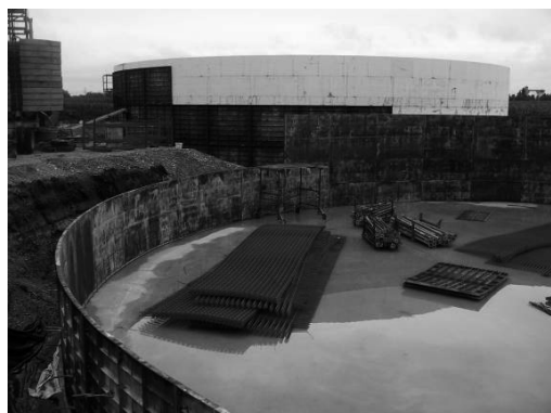
7.20.att. Uz vietas izveidots vertikālais betona bioreaktors (RUTZ, 2007)
