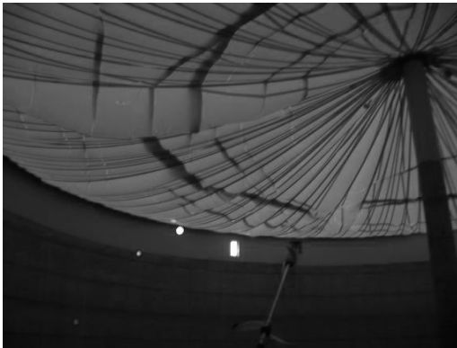
7.26.att. Gāznecaurlaidīga membrāna no tvertnes iekšpuses (pa kreisi) (AGRINZ GmbH, 2006). Bioreaktora pārsegums, kas aprīkots ar izplešanās tīklu (pa labi) (RUTZ, 2006)
