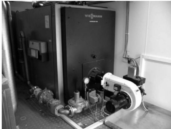
5.2.att. Biogāzes deglis siltuma ražošanai (AGRINZ GmbH, 2008)
