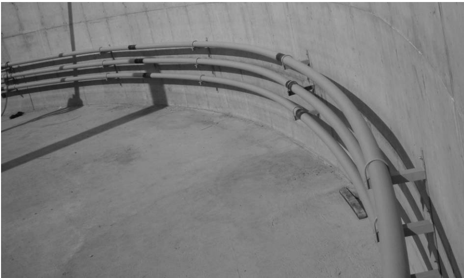
7.17.att. Bioreaktorā ievietotas apsildes caurules (AGRINZ GmbH, 2008)
