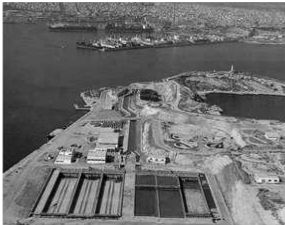
4.11.att. Notekūdeņu attīrīšanas stacija Psitalijā, Grieķijā (EYDAPSA, 2008)
