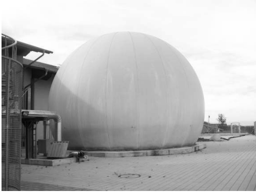
7.25.att. Ārējās zema spiediena gāzes uzglabāšanas tvertnes (RUTZ, 2007)
