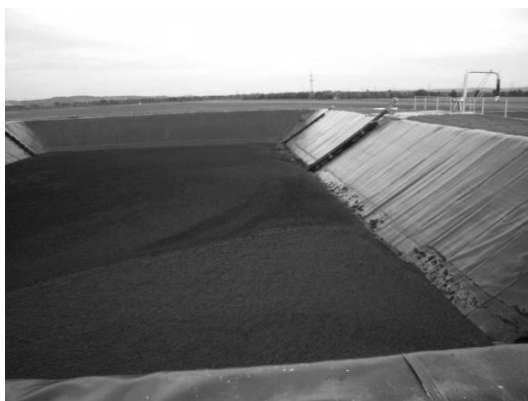
7.34.att. Atvērti nosēdbaseini pārstrādātā substrāta uzglabāšanai (AGRINZ GmbH, 2006)
