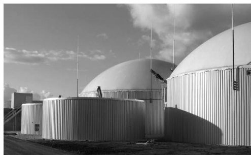
7.19.att. Vertikālie bioreaktori, kas apsegti ar gāznecaurlaidīgu membrānu (AGRINZ GmbH, 2008 – pa kreisi & RUTZ, 2006 – pa labi)
