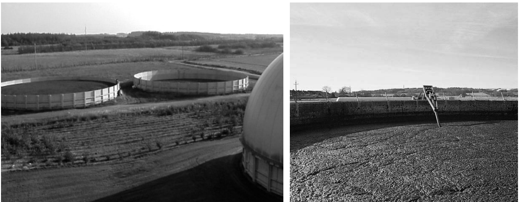
7.31.att. Uzglabāšanas tvertnes ar dabisku peldošu slāni (AL SEADI, 2008)
