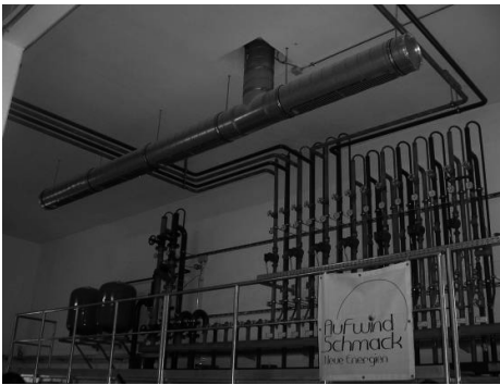
7.16.att. Biogāzes stacijas apsildes sistēma (pa kreisi) un betona bioreaktora izolācija remonta laikā (pa labi) (RUTZ, 2008)
