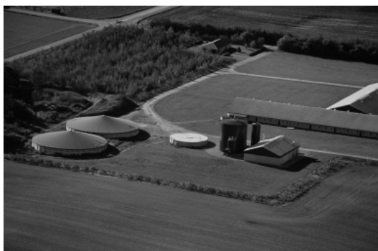
7.33.att. Ar membrānu segtas uzglabāšanas tvertnes (Dānijas Biogāzes asociācija, AL SEADI, 2008)
