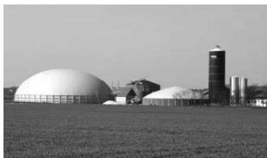
4.5.att. Vienai zemnieku saimniecībai domāta biogāzes stacija, kurā kofermentē dzīvnieku vircas un enerģētiskās kultūras Dānijā (GROENGAS A/S)
