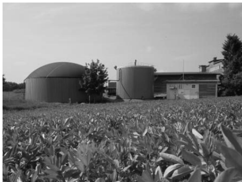
4.6.att. Vācijā esošs vertikālais bioreaktors, kas pārstrādā cūku un māļputnu kūtsmēslus un labības skābbarību (KRIEG & FISHER, 2008)
