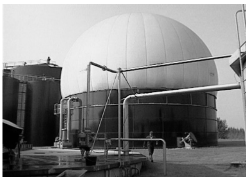
7.33.att. Ar membrānu segtas uzglabāšanas tvertnes (Dānijas Biogāzes asociācija, AL SEADI, 2008)
