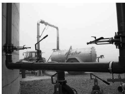
7.15.att. Izolēti gāzes cauruļvadi (pa kreisi) un pārstrādātā substrāta cauruļvadi (pa labi) (RUTZ, 2008)
