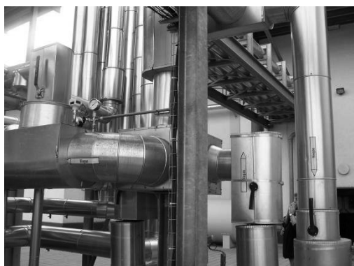
7.15.att. Izolēti gāzes cauruļvadi (pa kreisi) un pārstrādātā substrāta cauruļvadi (pa labi) (RUTZ, 2008)
