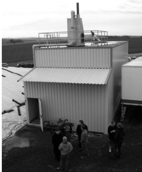
7.21.att. Horizontāls 400 m 3 liels plūsmas bioreaktors “EUCO®” Schmack Biogas (RUTZ, 2006)
