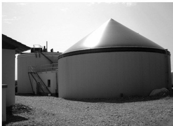
4.7.att. 2005.gadā Vācijā uzcelts vertikālais bioreaktors, kas fermentē enerģētiskās kultūras (KRIEG & FISHER, 2008)
