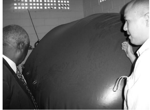
7.25.att. Ārējās zema spiediena gāzes uzglabāšanas tvertnes (RUTZ, 2007)
