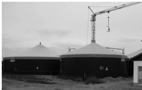
7.19.att. Vertikālie bioreaktori, kas apsegti ar gāznecaurlaidīgu membrānu (AGRINZ GmbH, 2008 – pa kreisi & RUTZ, 2006 – pa labi)
