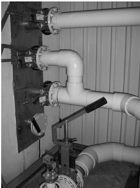
7.8.att. Apturēšanas ventiļi (pa kreisi) un sūknēšanas sistēma (pa labi) (RUTZ, 2006)
