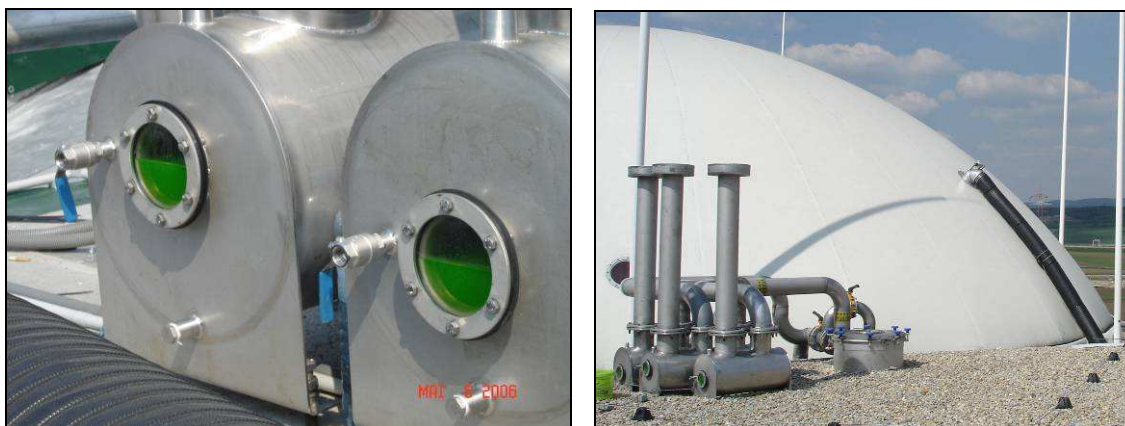
Фиг. 7.24 Съоръжения и вентили за безопасна работа под налягане (AGRINZ GmbH, 2006 г.)
