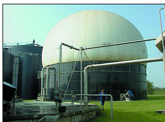
Фиг. 7.33 Резервоари за съхранение с мембранни покрития (Danish Biogas Association, 2008 г.)
