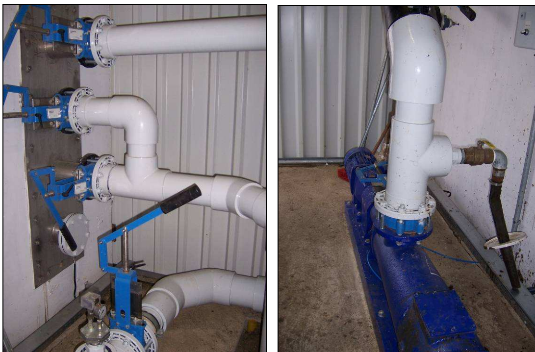
Фиг. 7.8 Стоп клапан (вляво) и помпена система (вдясно) (RUTZ, 2006 г.)
