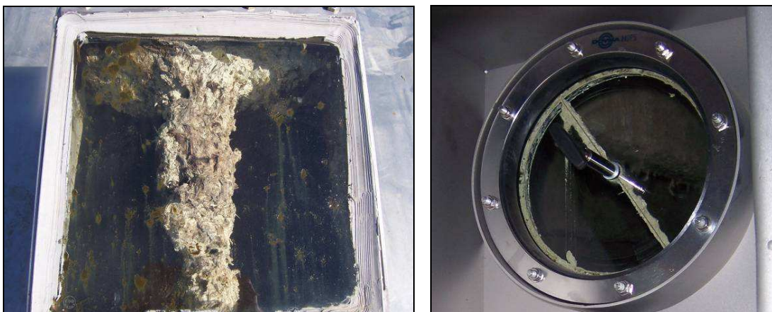
Фиг. 7.28 Елементна сяра, продукт на биологичната десулфуризация вътре в биореактора (RUTZ, 2007 г.)
