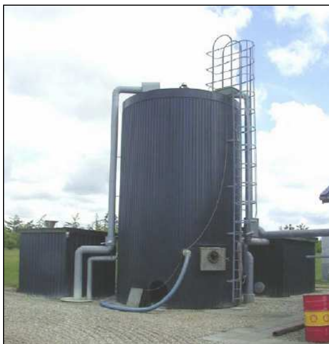
Фиг. 7.30 Резервоар-реактор за премахване на сероводород (ANGELIDAKI, 2005 г.)
