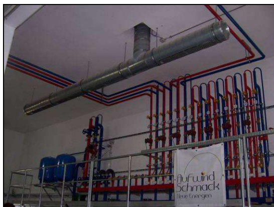
Фиг. 7.16 Отоплителна система на инсталация за производство на биогаз (вляво) и изолация на бетонен ферментатор в строеж (вдясно) (RUTZ, 2008 г.)
