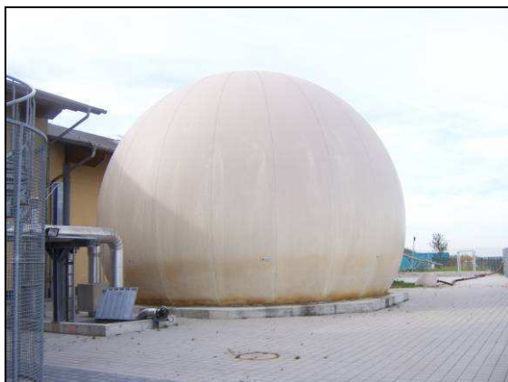
Фиг. 7.25 Външни резервоари за съхранение на газ, работещи под налягане (RUTZ, 2007 г.)
