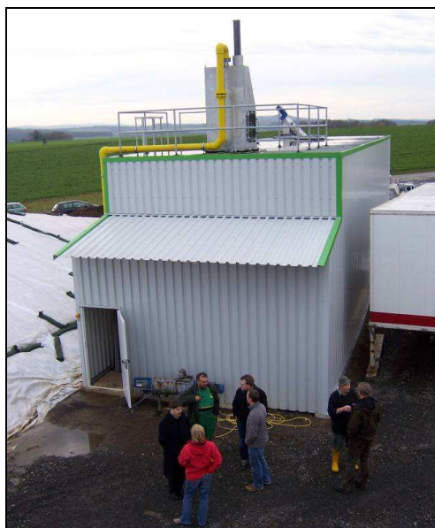
Фиг. 7.21 Хоризонтален проточен биореактор (RUTZ, 2006 г.)
