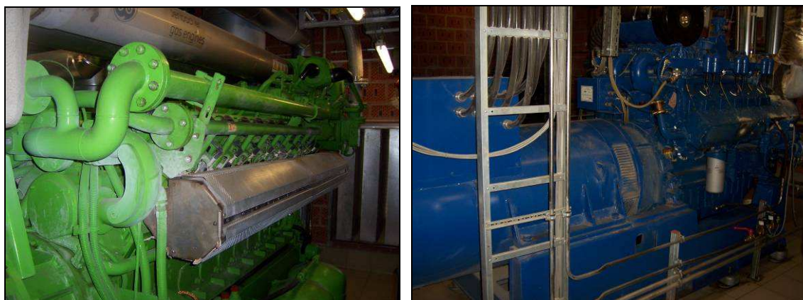
Фиг. 5.3 Газови двигатели на Ото (RUTZ, 2007 г.)
