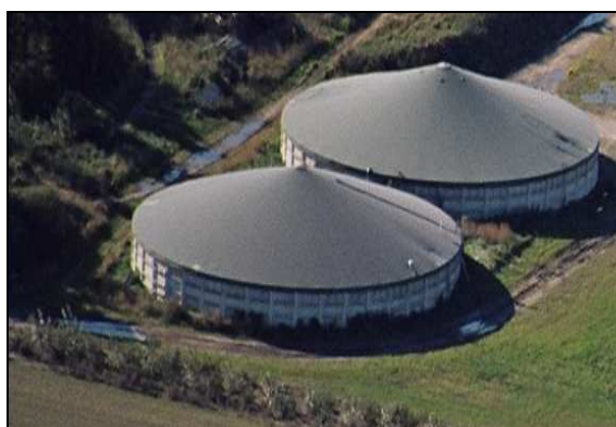
Фиг. 7.33 Резервоари за съхранение с мембранни покрития (Danish Biogas Association, 2008 г.)
