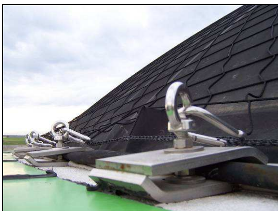
Фиг. 7.26 Биореактор покрит с мембрана, поглед от вътрешността на биореактора (вляво) (AGRINZ GmbH, 2006 г.) и поглед отвън (вдясно) (RUTZ, 2006 г.)
