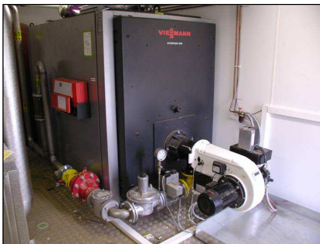
Фиг. 5.2 Бойлери, изгарящи биогаз за производството на топлина (AGRINZ GmbH, 2008 г.)
