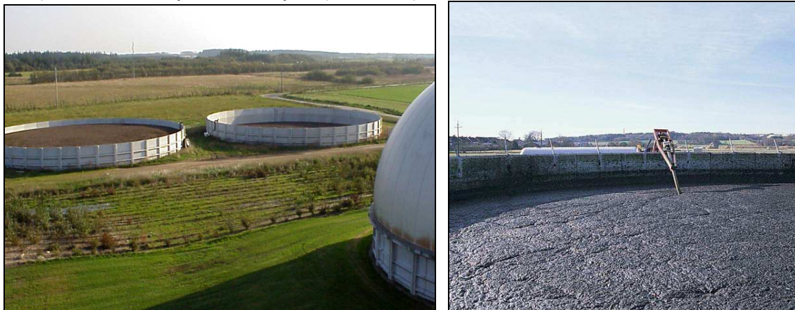
Фиг. 7.31 Съоръжения за съхранение с естествено плаващо покритие (Al SEADI, 2008 г.)
