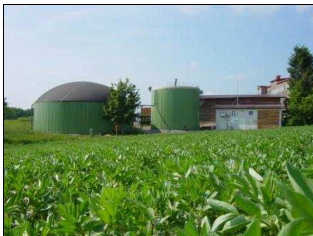
Фиг. 4.6 Вертикален биореактор в Германия, преработващ свинска и птича тор, както и силаж от посеви (KRIEG AND FISHER, 2008 г.)
