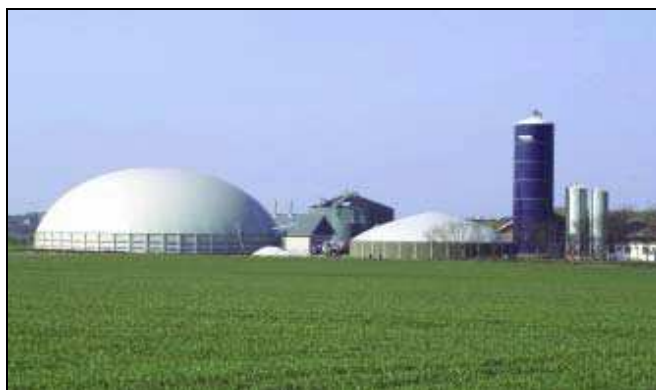
Фиг. 4.5 Фермерска инсталация за биогаз в Дания, ко-ферментираща течни торове и енергийни култури (GROENGAS A/S)
