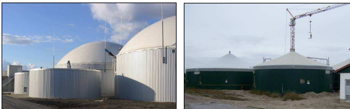
Фиг. 7.19 Вертикални биореактори, покрити с херметична мембрана (AGRINZ GmbH, 2008 г. – вляво и RUTZ, 2006 г.-вдясно)
