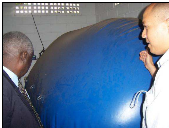
Фиг. 7.25 Външни резервоари за съхранение на газ, работещи под налягане (RUTZ, 2007 г.)
