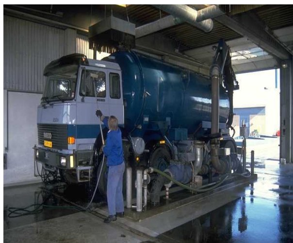
Фиг. 9.1 Стандартна процедура за почистване на транспортните средства в инсталацията за биогаз Рибе в Дания (AL SEADI, 2000 г.)
