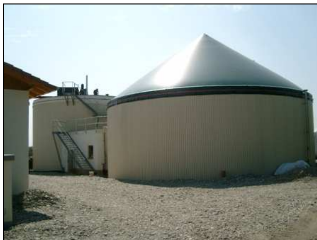
Фиг. 4.7 Вертикален биореактор, изграден в Германия през 2005г., за ферментация на енергийни култури (KRIEG & FISHER, 2008 г.)
