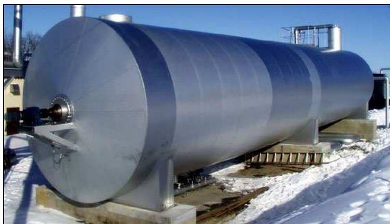
Фиг. 4.3 Хоризонтален биореактор, произведен в Дания (Nordisk Folkecenter, 2001 г.)
