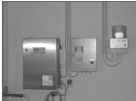
Abb. 3-45: Prozessvisualisierung und zentrale Messdatenerfassung; Bilder: Awite Bioenergie GbR
