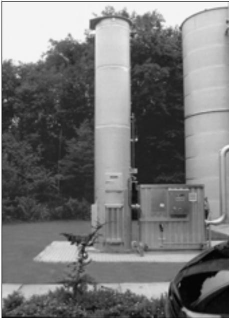
Abb. 3-43: Notfackel einer Biogasanlage;
