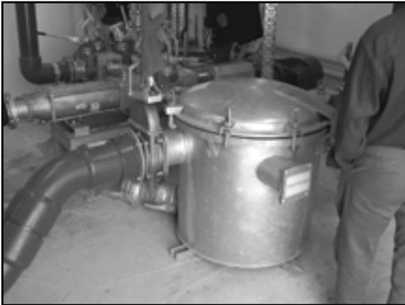
Abb. 3-29: Schwerstoffabscheider in einer Rohrleitung;
