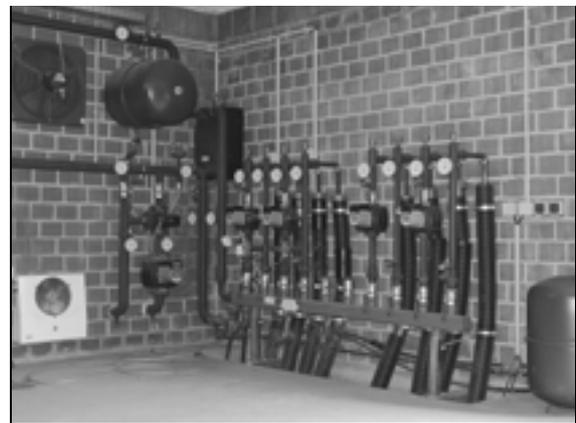
Abb. 5-6: Heizverteiler; Foto: MT-Energie-GmbH
