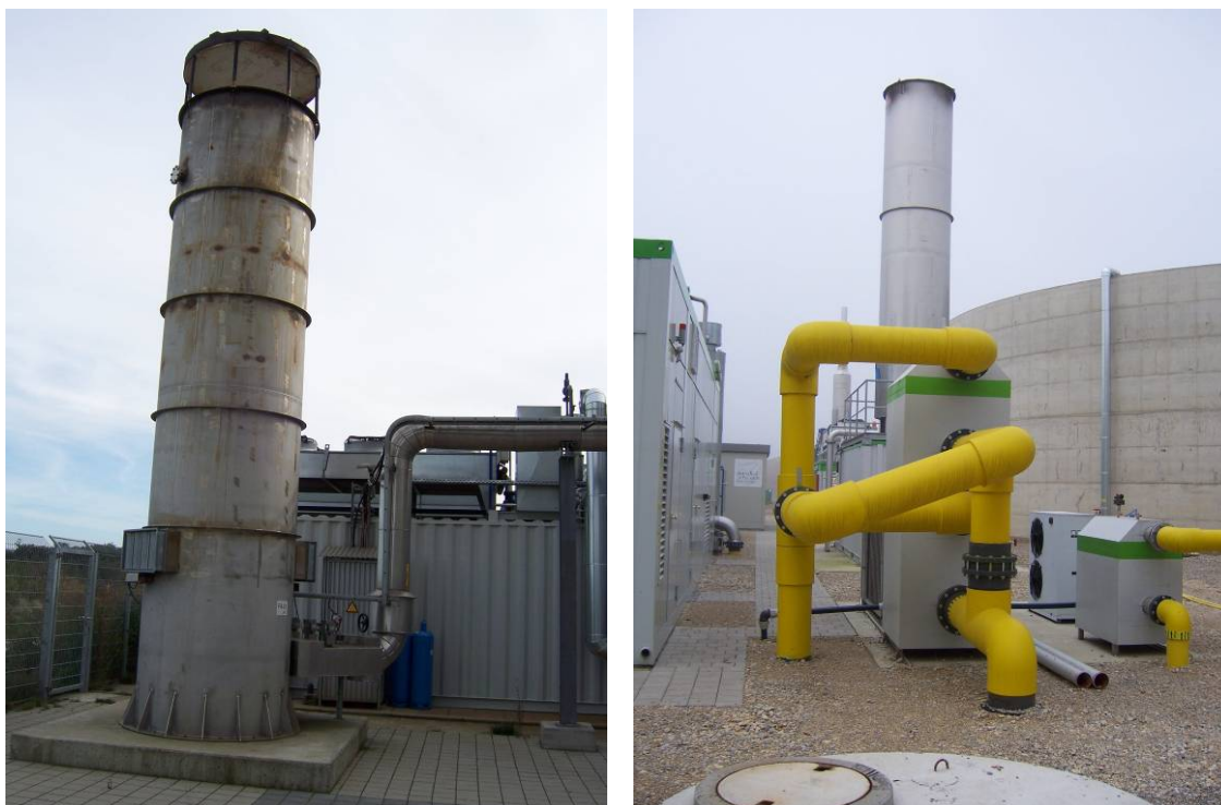
Figura 7.27. Arzătoare moderne de biogaz (RUTZ, 2007)
