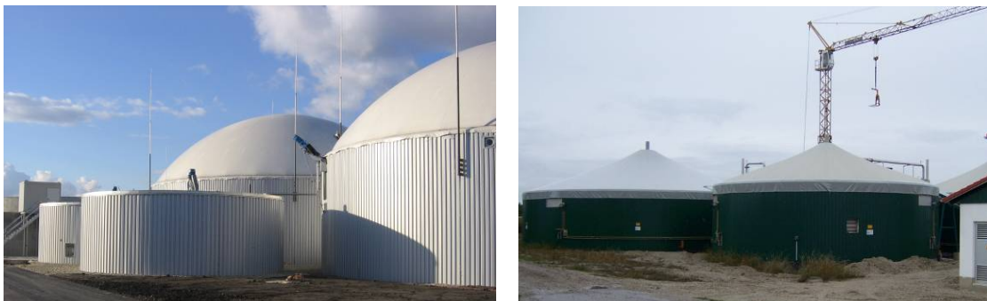
Figura 7.19. Digestoare verticale, acoperite cu membrane impermeabile pentru gaze (AGRINZ GmbH, 2008) - stânga și (RUTZ, 2006) - dreapta
