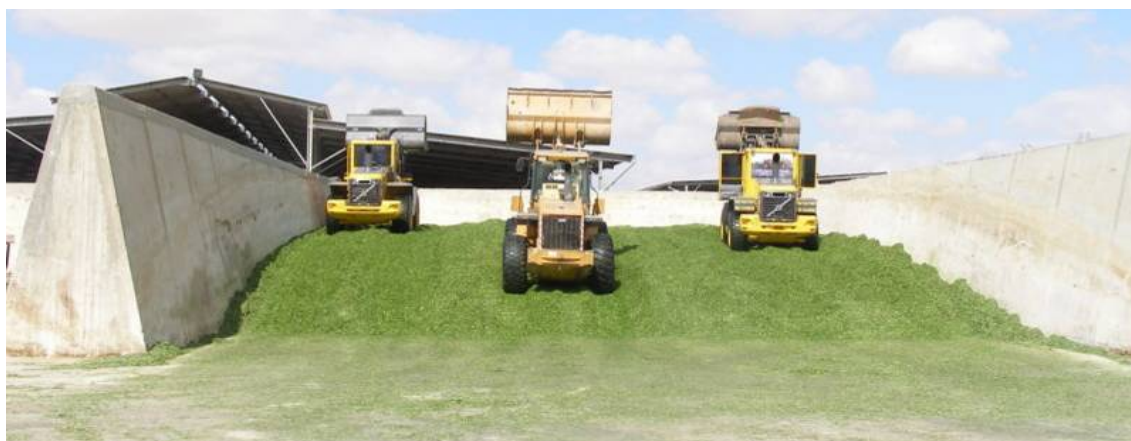
Figura 7.5. Siloz de tip buncăr (WIKIPEDIA, 2008)
