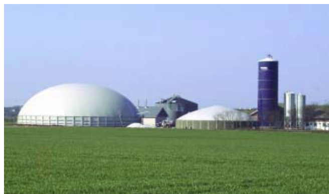
Figura 4.5. Imagine a unei fabrici de biogaz de nivel fermier din Danemarca, de co-digestie a gunoiului animal și a materialului provenit din culturi energetice (GROENGAS A/S)
