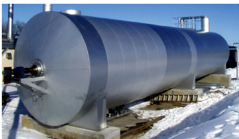
Figura 4.3. Digester orizontal, construit în Danemarca (Nordisk Folkecenter, 2001)
