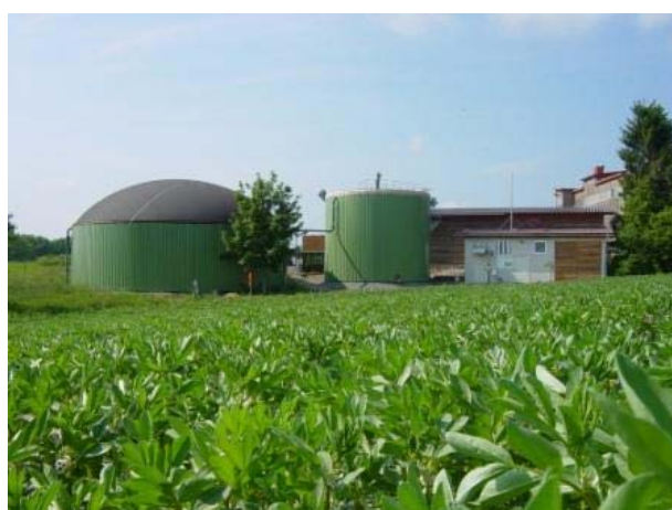
Figura 4.6. Digester vertical din Germania, pentru procesarea dejecțiilor provenite din fermele de porci și păsări și a biomasei vegetale însilozate (KRIEG AND FISHER, 2008)
