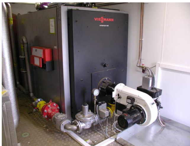
Figura 5.2. Cuptor cu biogaz pentru producerea căldurii (AGRINZ GmbH, 2008)
