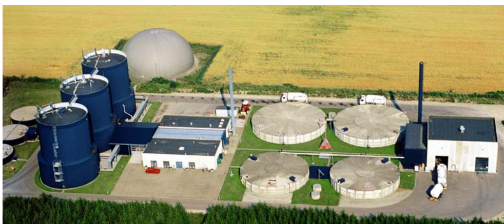
Figura 4.8. Imagine a unei fabrici de co-digestie centralizată din Danemarca (LEMVIG BIOGAS)
