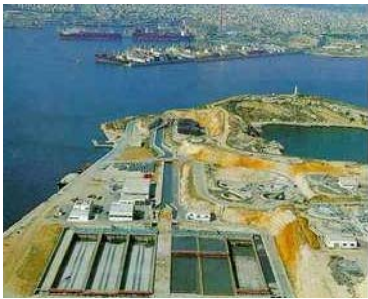
Figura 4.11. Uzină pentru tratarea apelor uzate din Psyttalia, Grecia (EYDAPSA, 2008)
