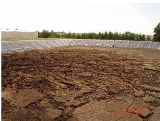
Figura 7.34. Stocarea digestatului în bazine construite în aer liber (AGRINZ GmbH, 2006)
