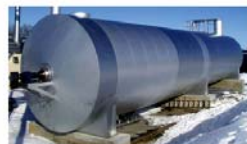
Slika 43. Horizontalni digestor izrađen u Danskoj Izvor: Nordisk Folkesenter, 2001.
