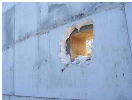
Slika 7.16. Sustav grijanja bioplinskog postrojenja (lijevo) i toplinska izolacija betonskog fermentatora u izgradnji (desno)
