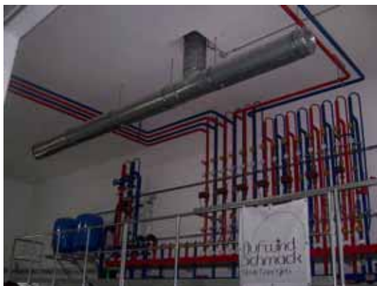
Slika 7.16. Sustav grijanja bioplinskog postrojenja (lijevo) i toplinska izolacija betonskog fermentatora u izgradnji (desno)
