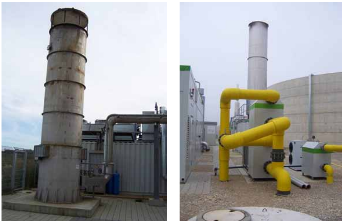
Slika 7.28. Moderne baklje za bioplin
