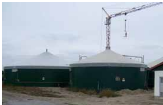
Slika 7.19. Vertikalni fermentatori pokriveni membranom koja ne propušta plin (lijevo: napuhana membrana i desno: membrana pričvršćena za stup)
