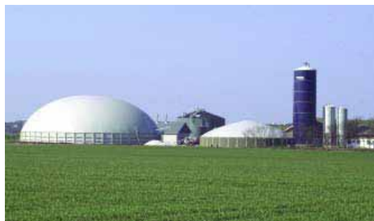
Slika 4.5. Postrojenje za proizvodnju bioplina na farmi u Danskoj, kodigestija stajskog gnoja i energetskih usjeva
