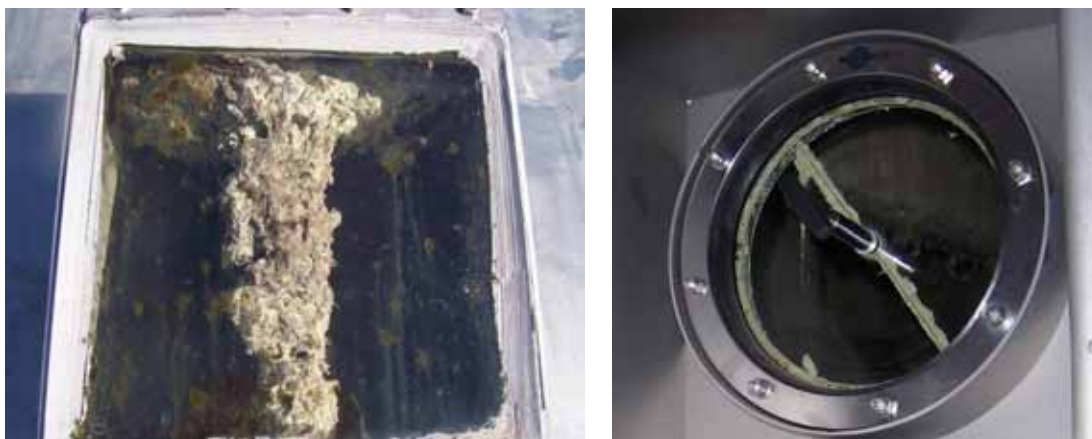
Slika 7.29. Elementarni sumpor, rezultat biološke desumporizacije unutar fermentatora
