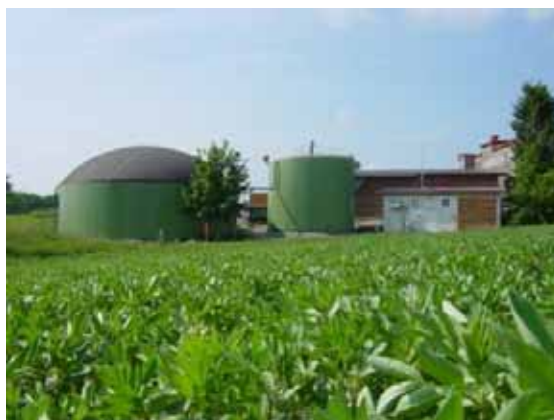
Slika 4.6. Vertikalni digester u Njemačkoj , prerada svinjskog i gnoja peradi i silaže
