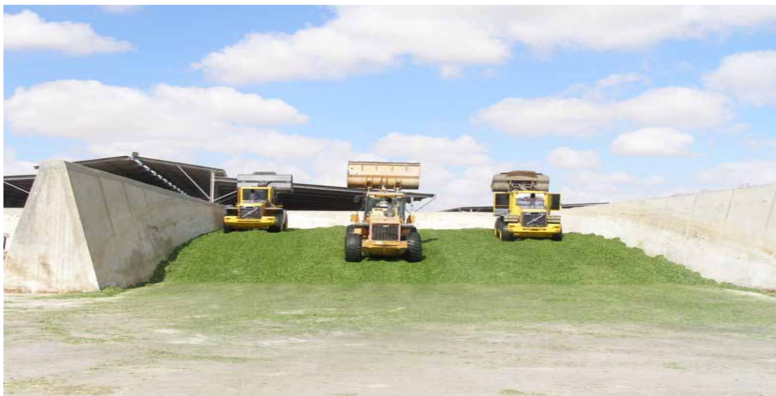
Slika 7.5. Bunker silos
