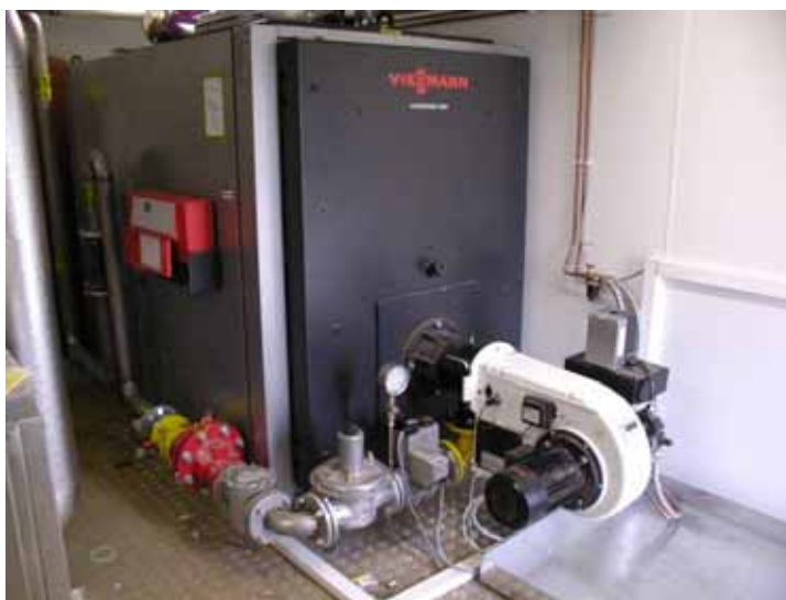
Slika 5.2. Plamenik za proizvodnju toplinske energije iz bioplina
