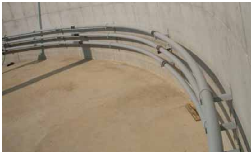
Slika 7.17. Cijevi za grijanje instalirane unutar fermentatora
