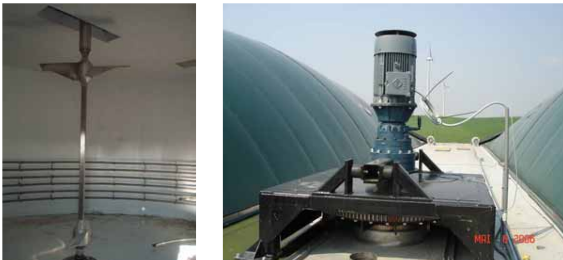
Slika 7.23. Viseća miješalica s lopaticama (lijevo) i njezin motor (desno)
