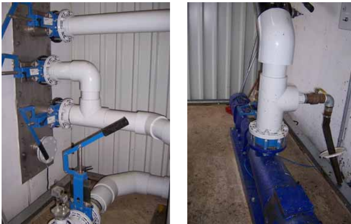
Slika 7.8. Zaustavni ventili (lijevo) i sustav za pumpanje (desno)
