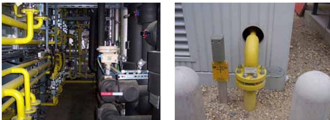
Slika 5.7. PSA nadogradnja metana (lijevo) i spoj sa mrežom prirodnog plina (desno) biometanskog postrojenja u Plieningu, Njemačka
